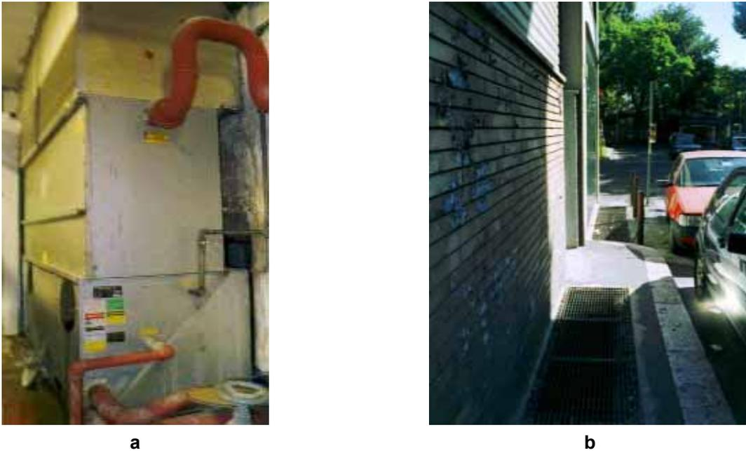
**Figura 3. Esercizio commerciale A: torre di raffreddamento (a), griglia di espulsione dell'aria dell'impianto di condizionamento situata a livello del marciapiede (b)**
